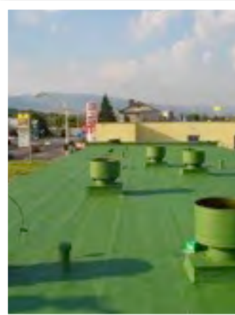
Aplikácia striekaním asf.strecha 700m 2
