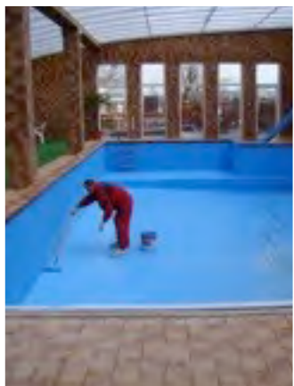
Aplikácia náterom bazén 280m 2
