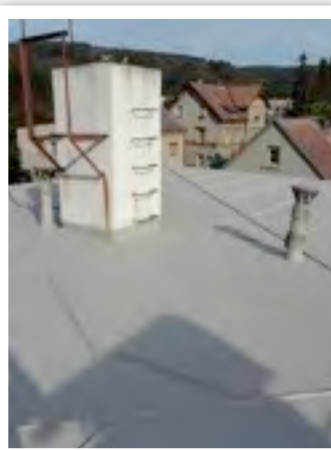
Aplikácia striekaním plech.strecha 320m 2
