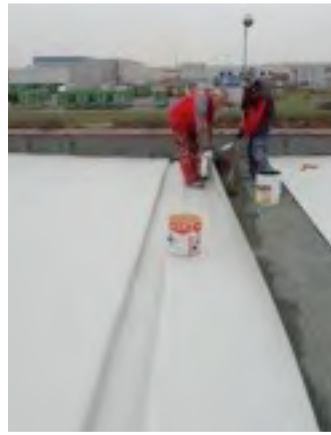
Hydroizolacia špec.membrány TG
