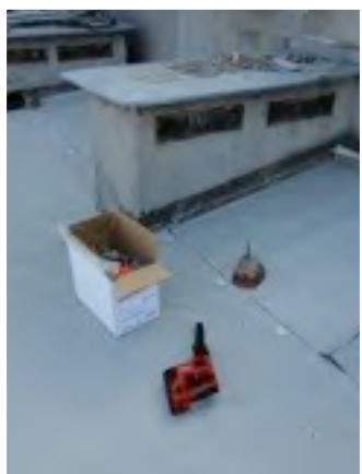
Hydroizolacia špec.membrány TG
