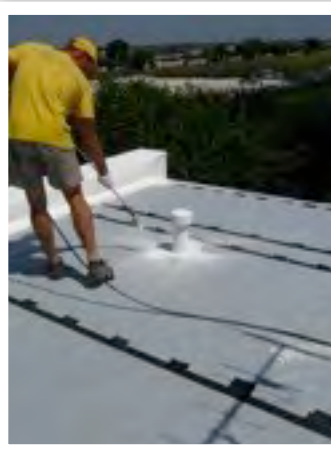
Hydroizolácia špec.membrány +zateplenie
