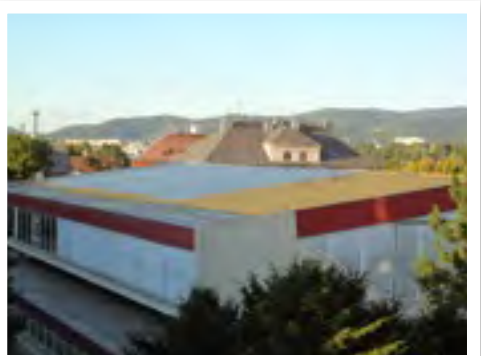
Hydroizolacia T.G na PUR
