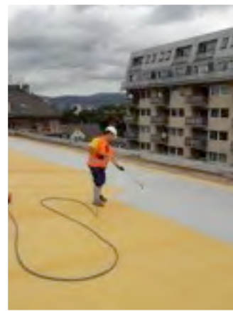
Hydroizolacia T.G na PUR
