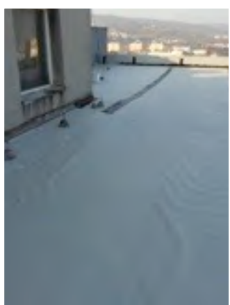
Hydroizolacia špec.membrány TG
