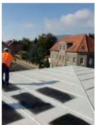
Aplikácia striekaním plech.strecha 320m 2
