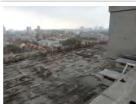
Oprava starej strechy
