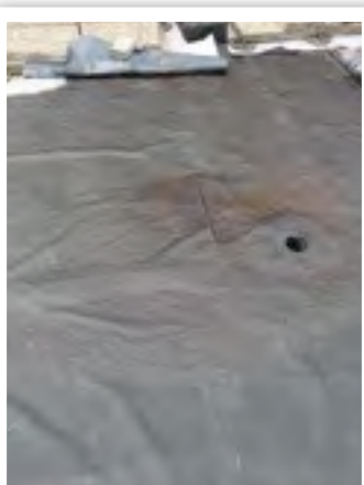
Hydroizolacia špec.membrány TG
