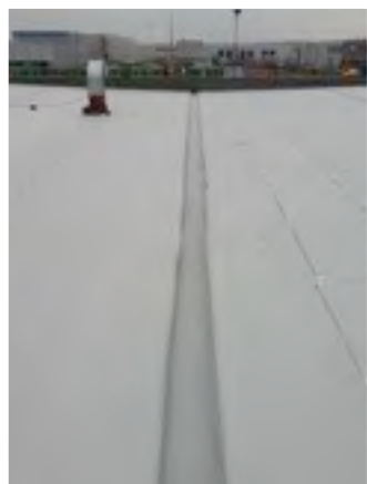
Hydroizolacia špec.membrány TG
