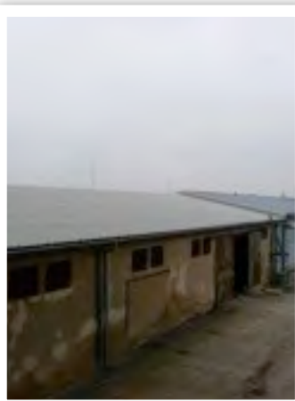
Aplikácia striekaním plech.strecha 1400m 2
