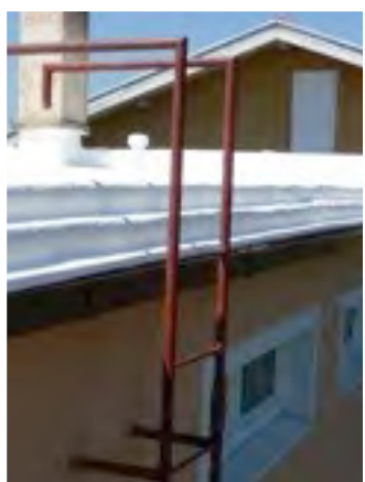
Hydroizoalcia špec.membrány TG +zateplenie
