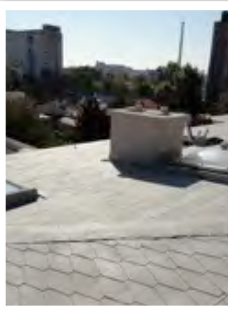
Hydroizolacia špec.membrány TG
