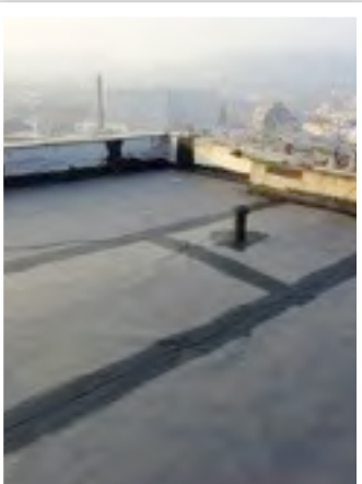
Hydroizolacia špec.membrány TG
