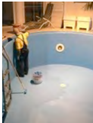
Aplikácia náterom bazén 120m 2
