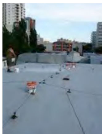
Aplikácia náterom asf.strecha 480m 2
