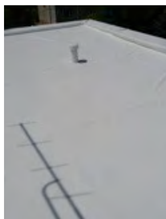
Hydroizolácia špec.membrány TG +zateplenie
