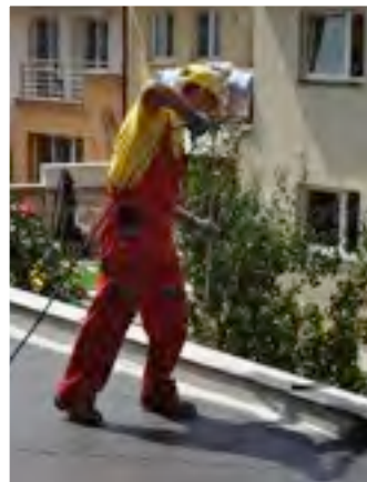
Hydroizolacia špec.membrány TG
