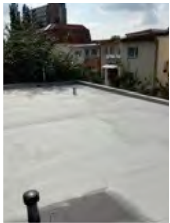
Hydroizolacia špec.membrány TG
