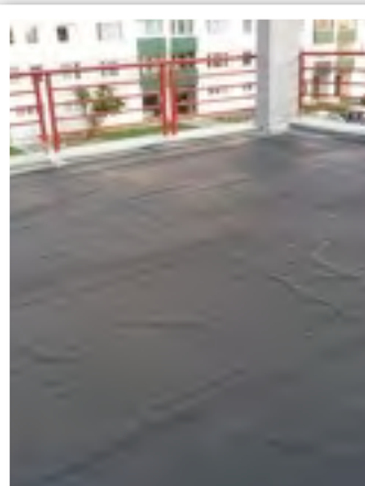
Hydroizolacia špec.membrány TG
