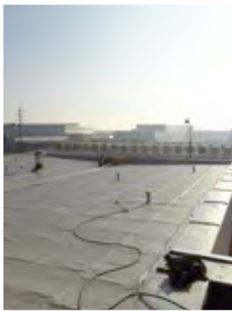
Hydroizolacia špec.membrány TG
