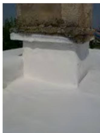
Hydroizolacia špec.membrány TG +zateplenie
