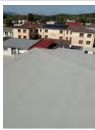
Hydroizolacia špec.membrány TG
