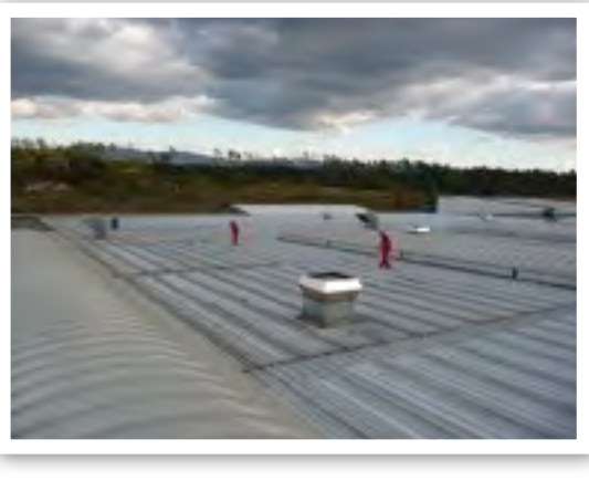
Aplikácia striekaním plech.strecha 20000m 2
