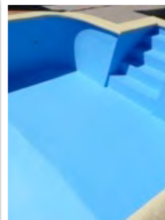
Aplikácia striekaním bazén 200m 2
